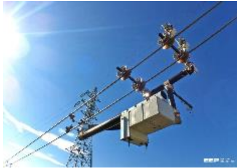
做對人類太危險的事： 電力檢測機器人
